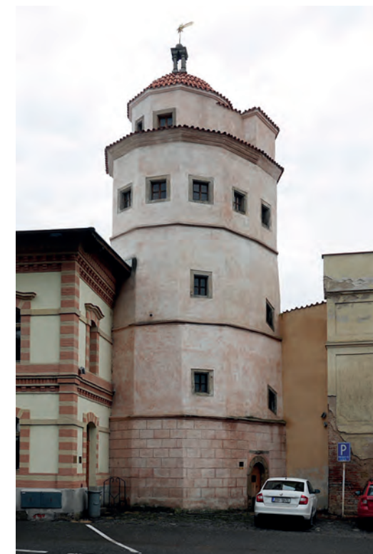
Předindustriální období Nymburk, vodárenská věž Vodní hospodářství předindustriálního období reprezentují především stavby a objekty spojené se zásobováním vodou, náhony a rybníky. „Nejviditelnějšími“ součástmi vodovodních systémů jsou vodárenské věže (věžové vodojemy) a kašny. Renesanční šestiboká vodárenská věž v Nymburce, tzv. Turecká, postavená koncem 16. století, jímala vodu z Labe pro napájení městské kašny. V provozu byla do 2. poloviny 19. století. Zařízení nedochováno. Foto Michaela Ryšková, 2017.
