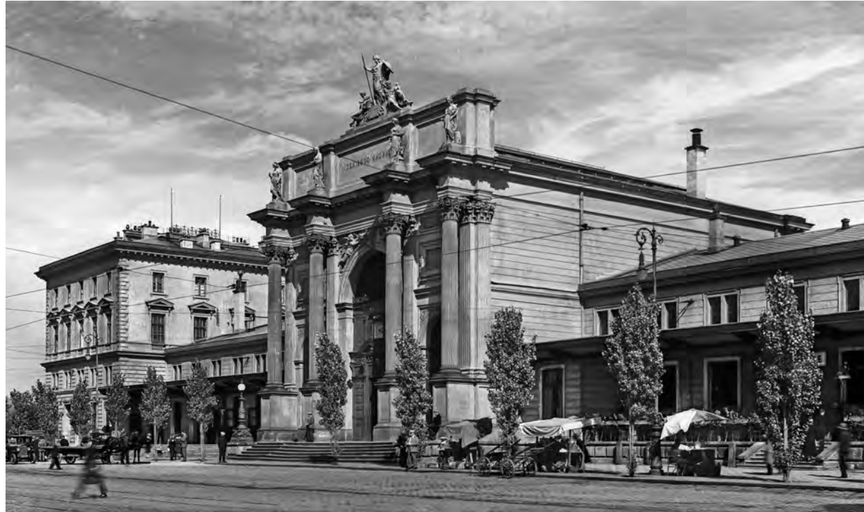
Praha, výpravní budova železniční stanice Praha-Těšnov Snímek z 40. let 20. století. NPÚ, generální ředitelství, archiv fotografií, č. negativu N155401.
