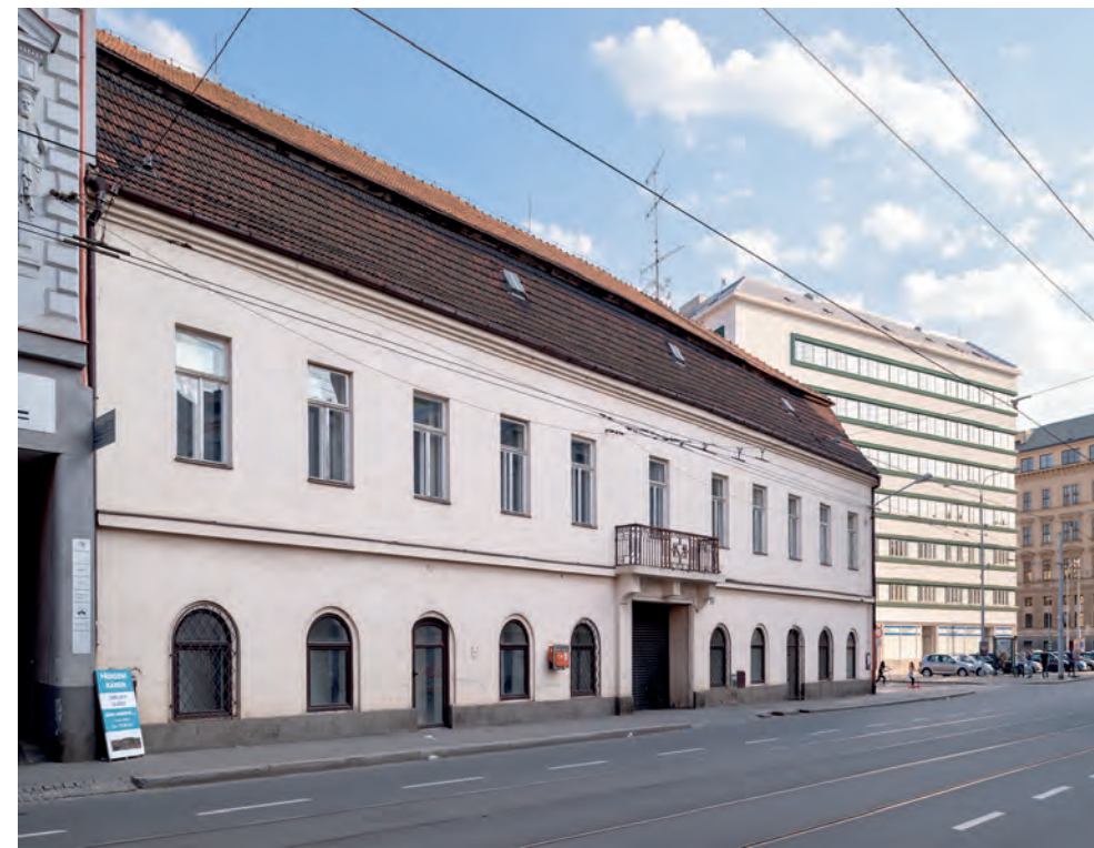
Předindustriální období Brno, soukenická manufaktura Karla Přízy Výrobní budovy předindustriálního období vycházely z dobových vzorů a zvyklostí. Soukenická manufaktura Karla Přízy byla na jižní straně Cejlu založena v roce 1810. V uličním průčelí byla situována zřejmě obytná část a zázemí manufaktury a vlastní výrobu sloužila kolmá křídla. Podobné řešení bylo uplatněno například u nedochované státní soukenické manufaktury, založené v Brně v roce 1764. Foto Viktor Mácha, 2018.
