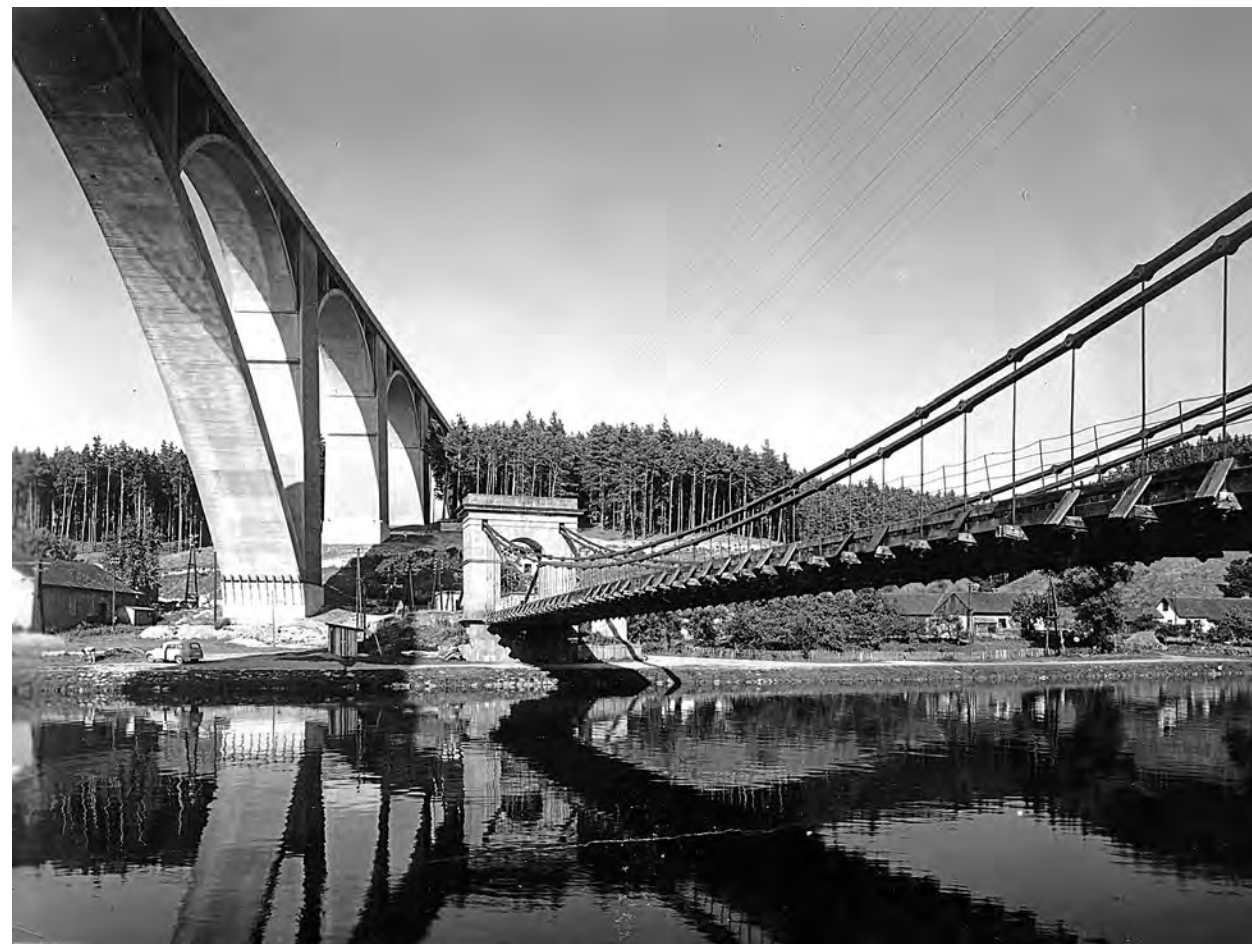
Zachování průmyslového dědictví – transfer Stádlec, řetězový most Nejvýznamnější příklad přenosu nemovité památky technické povahy na území České republiky představuje transfer empírového řetězového mostu postaveného v letech 1847–1848 stavitelem Vojtěchem Lannou přes Vltavu poblíž obce Podolsko na silnici z Písku do Tábora (na trase z Bavorska do Haliče). V roce 1960 byl rozebrán a ze svého původního místa, zatopeného o málo později Orlickou přehradou, přenesen na Lužnici k obci Stádlec, kde byl po sestavení slavnostně otevřen roku 1975. Slouží svému původnímu účelu, provoz je však omezen pouze pro osobní dopravu. Jde o jediný dochovaný empírový řetězový most na území republiky. Foto NPÚ, GnŘ, archiv fotografií, Vladimír Hyhlík (archivní snímek z doby před rozebráním); NPÚ, GnŘ, archiv, dokumentace provádějící transfer; Eva Dvořáková (současný stav).
