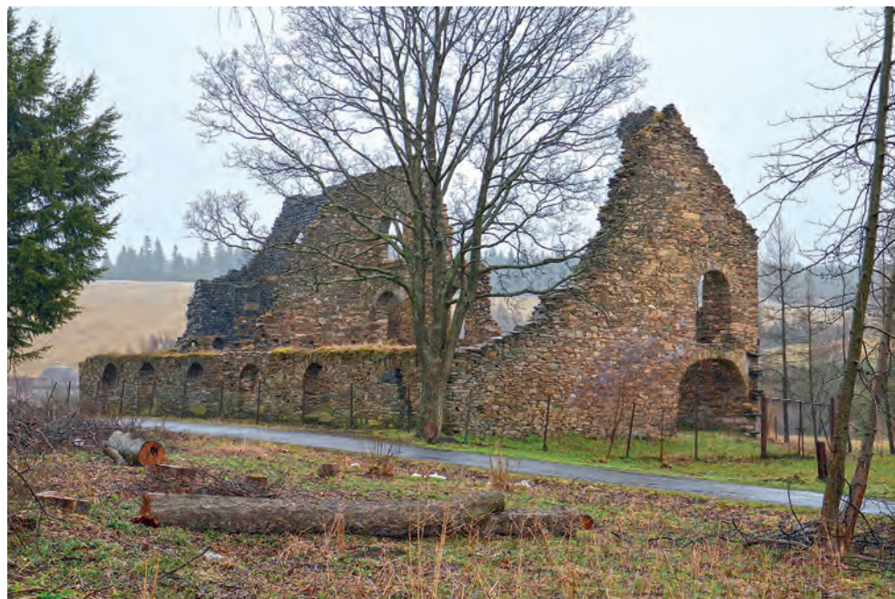
Předindustriální období Kovářská, uhelna Železářská výroba v Kovářské je nepřímými prameny doložena od 15. století. Dřevouhelná vysoká pec, vystavěná zde roku 1597, byla druhou vysokou pecí v českých zemích. Na vysokopecní provoz navázaly hamry, brusárna a kovárna (uváděné v roce 1728). Výroba byla ukončena v roce 1869. Posledními doklady železářské výroby je dvojice vápenických pecí, které byly v provozu až do 20. let 20. století, a ruiny bývalého skladu dřevěného uhlí, zvaného uhelna. Monumentální třípodlažní budova byla kompletně vyžděna z kamenného zdiva, které mělo bránit případnému šíření požáru mezi jednotlivými skladovacími komorami. Foto Ondřej Malina, 2013.
